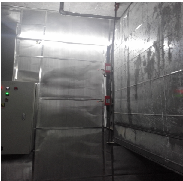
图 2 地下风机房隔音墙
