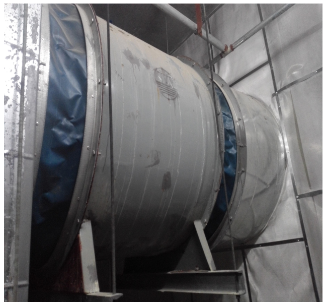
图 3 地下风机房软连接处
